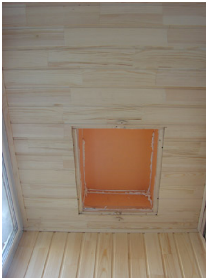
Отделка пожарного люка на потолке балкона
