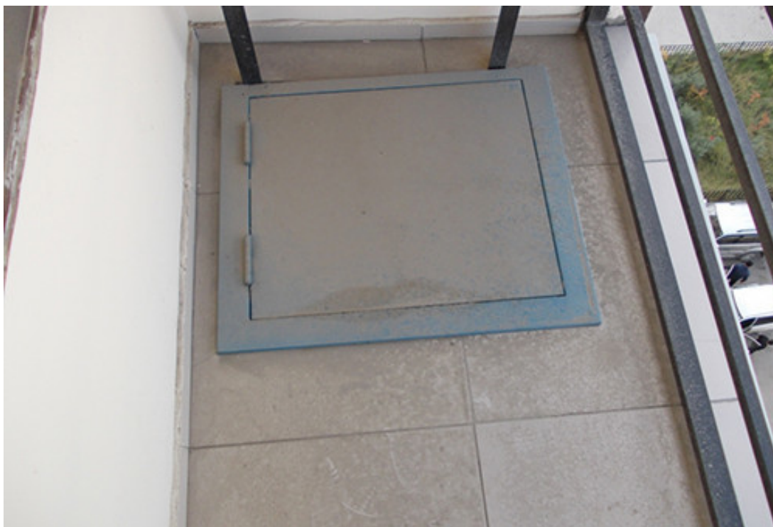
Отделка пожарного люка на балконе
